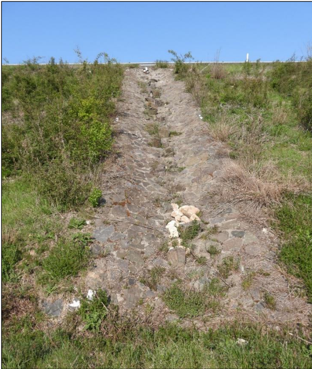
Abbildung 3: Eine der an die Autobahn grenzenden Entwässerungsrinnen.
